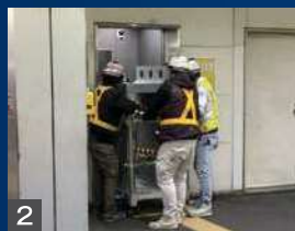
2 基礎運搬 (エレベーター使用)
