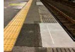
コンクリート・滑止め塗装
