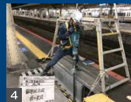
4 小径鋼管杭打設 (人力施工)
