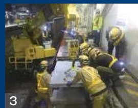
3 基礎設置 (軌陸クレーン使用)
