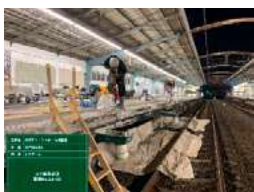
コア削孔、削孔水回収
